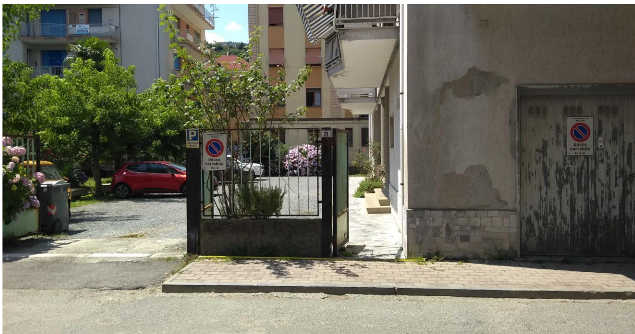
FOTO 4 - via Cordoba - pavimentazione in parte esistente, su cui si realizzeranno rampe per diversamente abili
