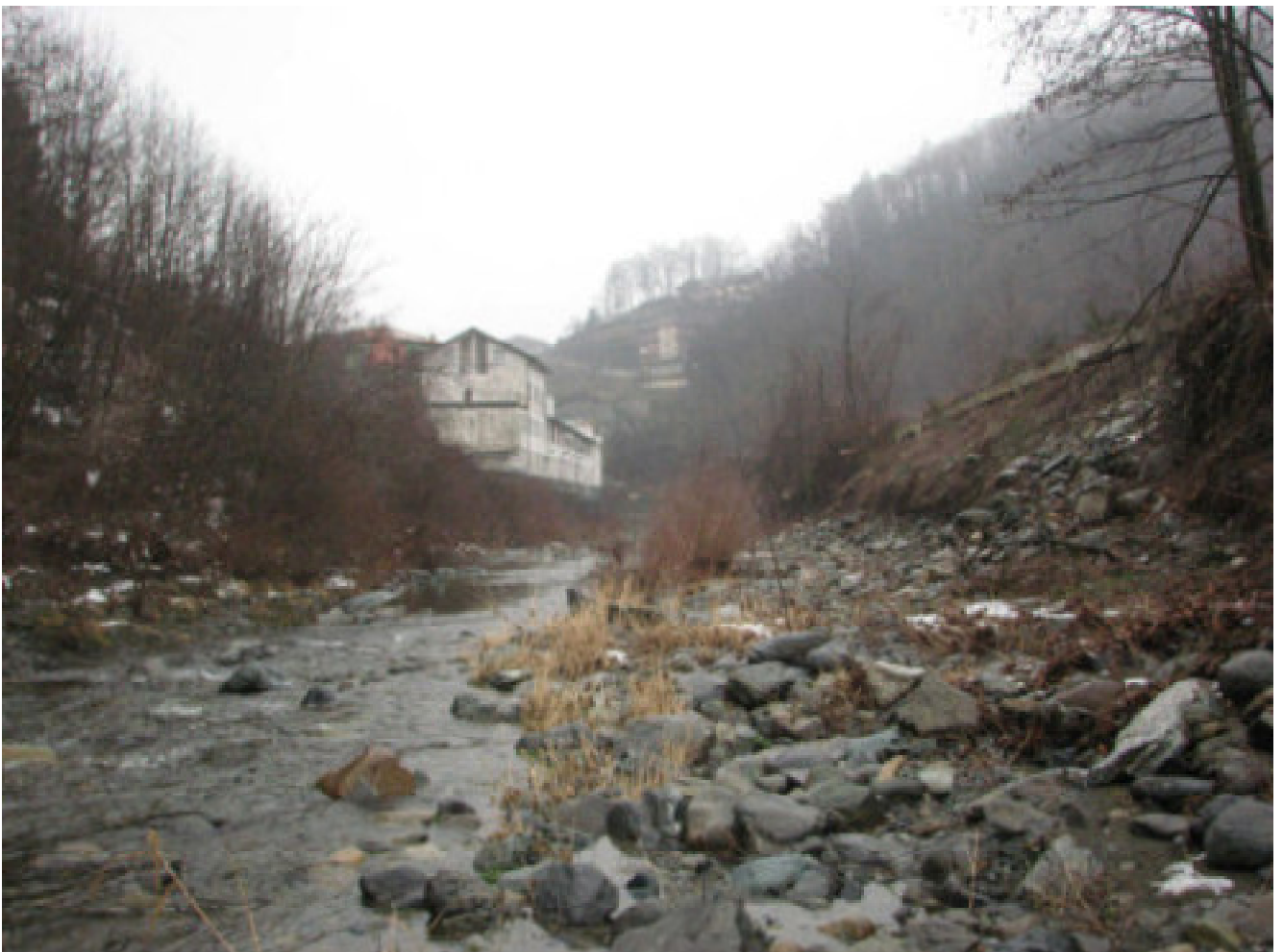
FOTO N.6 - INTERVENTO 2 - VISTA DALL'ALVEO DELLA FRANA IN SPONDA DESTRA
