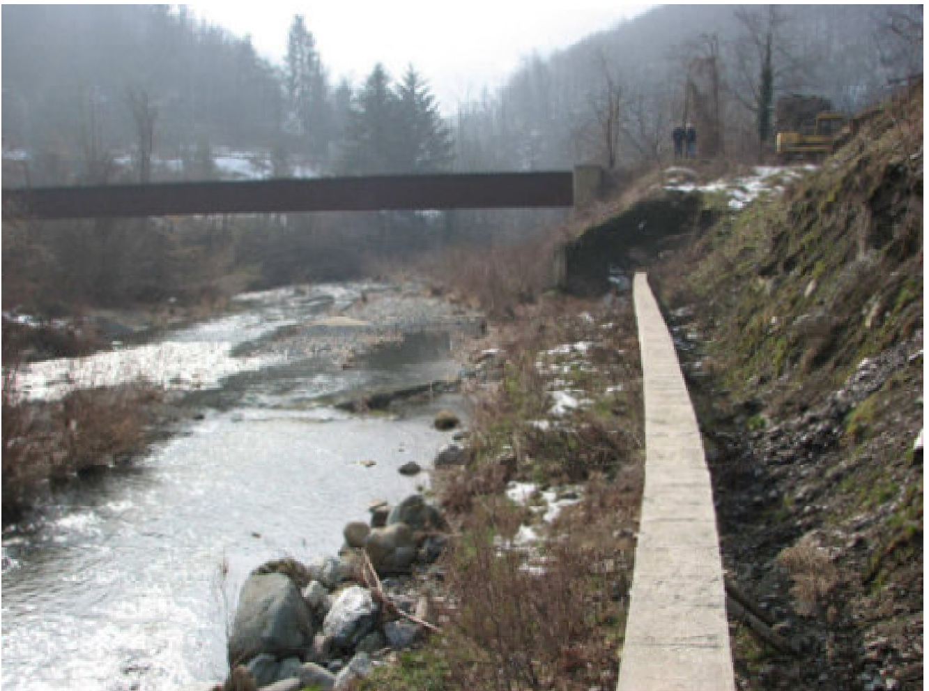
FOTO N. 4 - INTERVENTO 1 – VISTA VERSO IL PONTE
