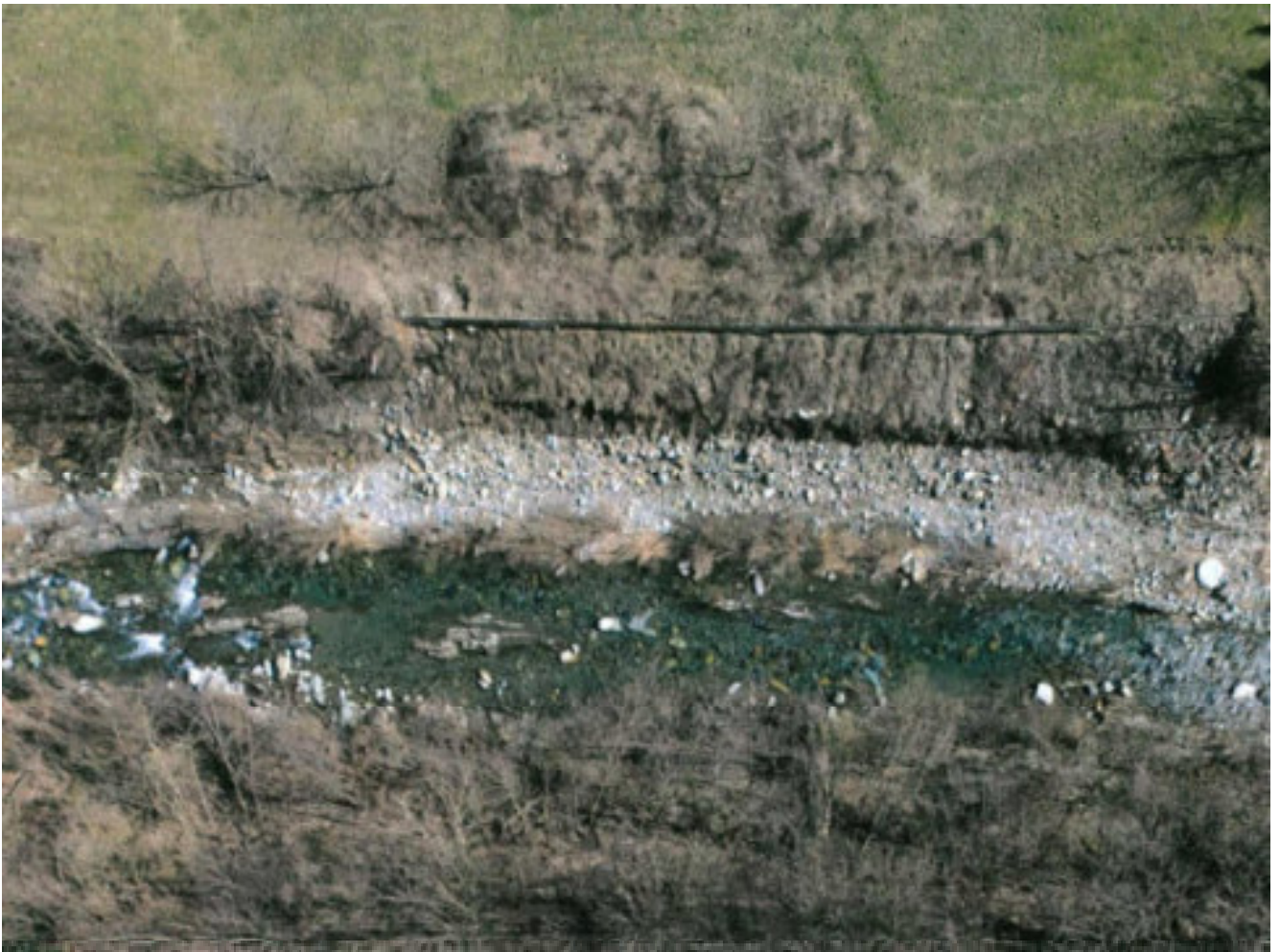
FOTO N.5 - INTERVENTO 2 - VISTA AEREA (FOTO CON DRONE)
