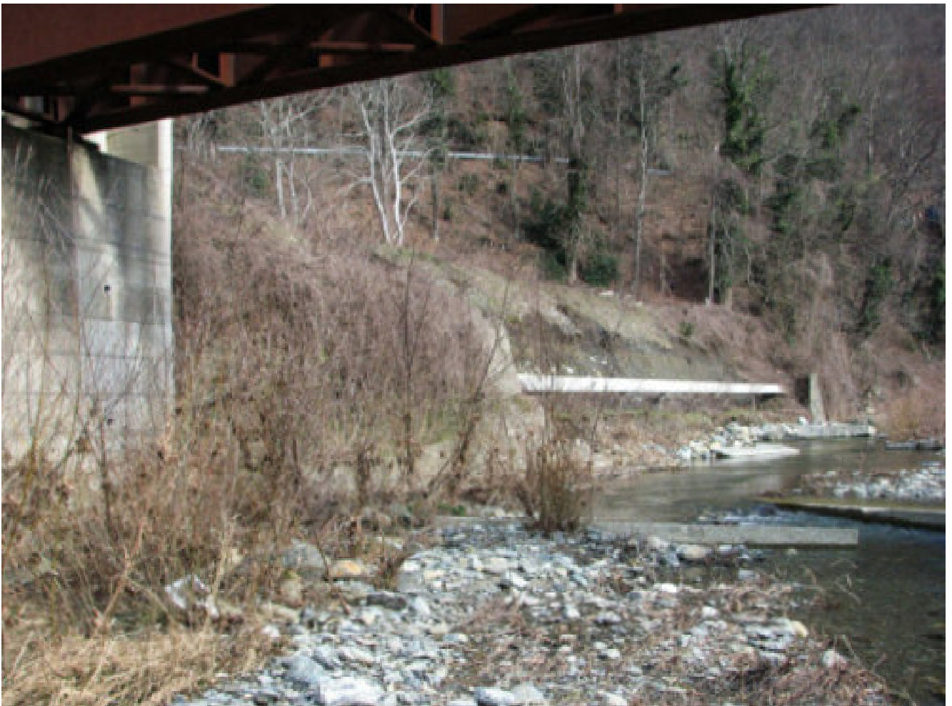
FOTO N. 2 - INTERVENTO 1 - VISTA DALL'ALVEO (sotto al ponte)
