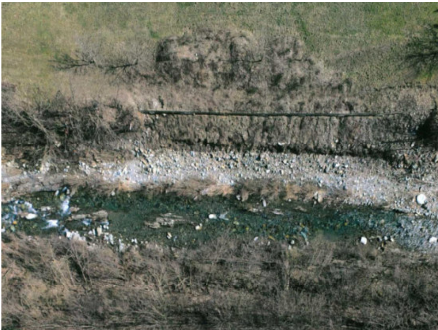
FOTO N. 3 - INTERVENTO 2 -Vista aerea del tratto interessato (foto drone).
