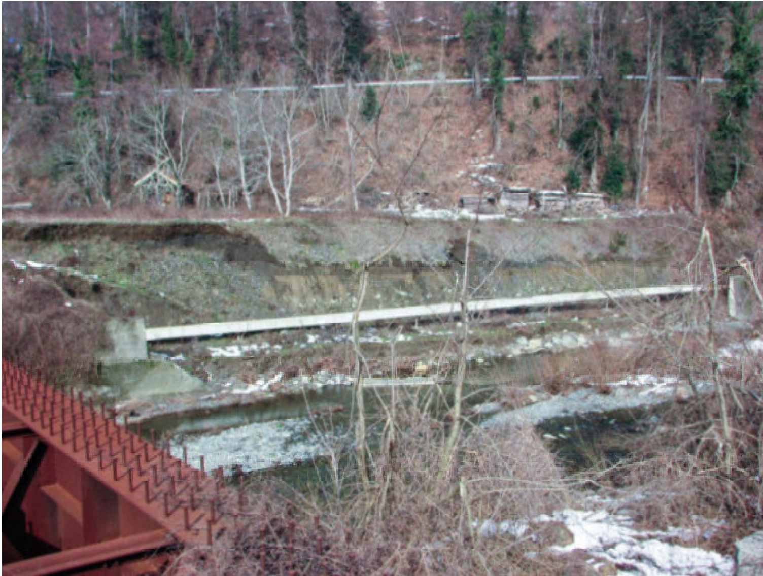
FOTO N. 1 - INTERVENTO 1 -Vista dal ponte, lato sponda sinistra del Torrente Stura
