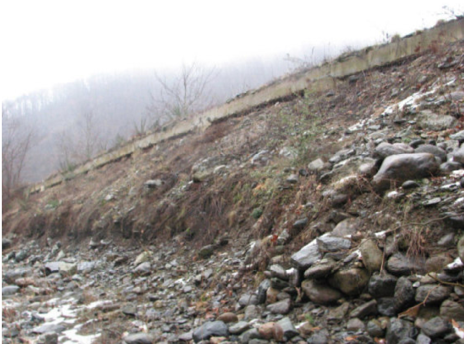
FOTO N. 4 - INTERVENTO 2 -Vista dall'alveo del Torrente Stura.
