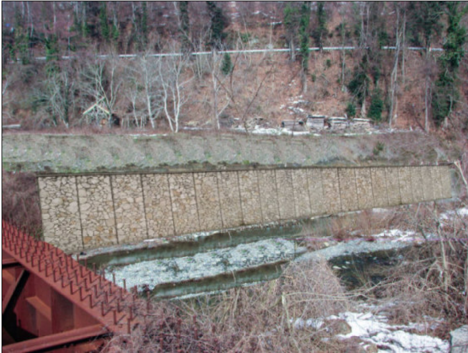
Immagine 2 – Intervento 1 - Inserimento del muro di sostegno e sistemazione scarpata su foto n.1 (vedi elaborato A04)
