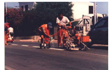
SEGNALETICA STRADALE ORIZZONTALE
