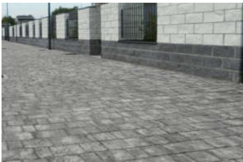
Fig.1 - massello autobloccante tipo - schema di posa
