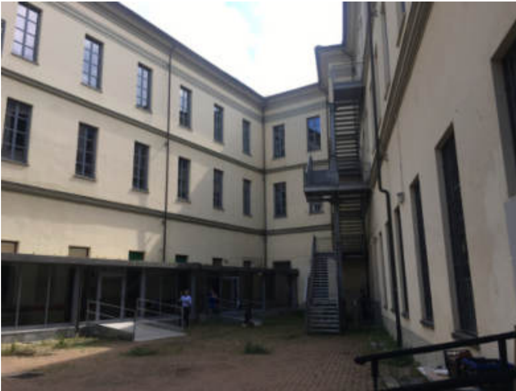
Facciate interne cortile
