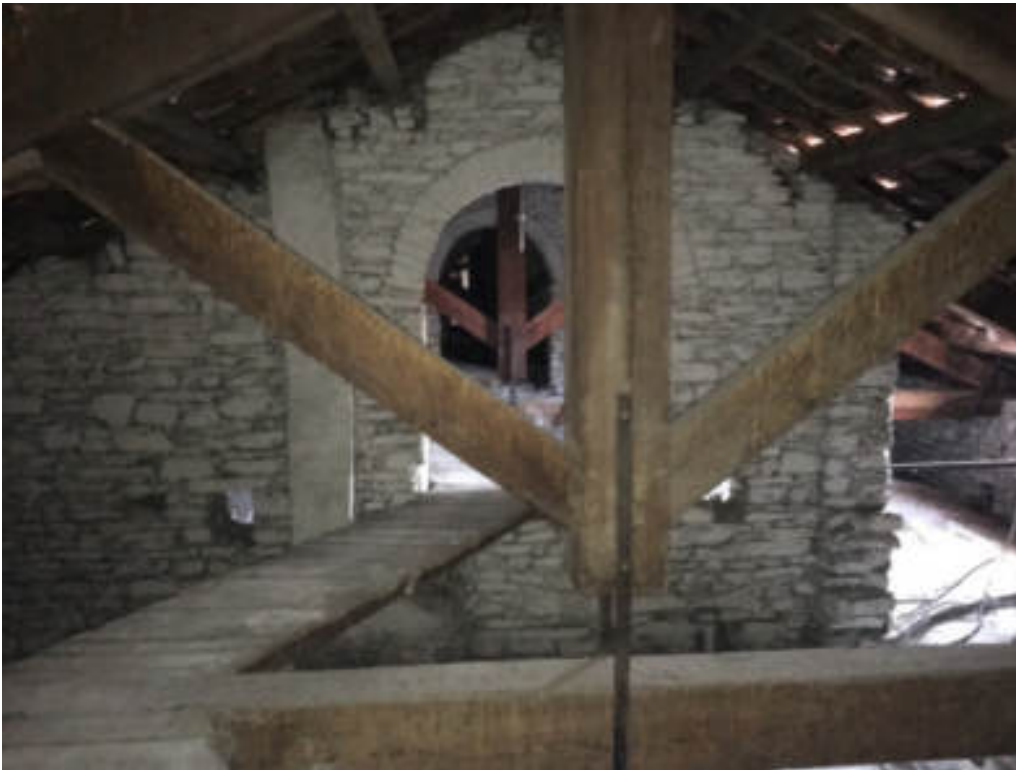
Particolare capriata sottotetto
