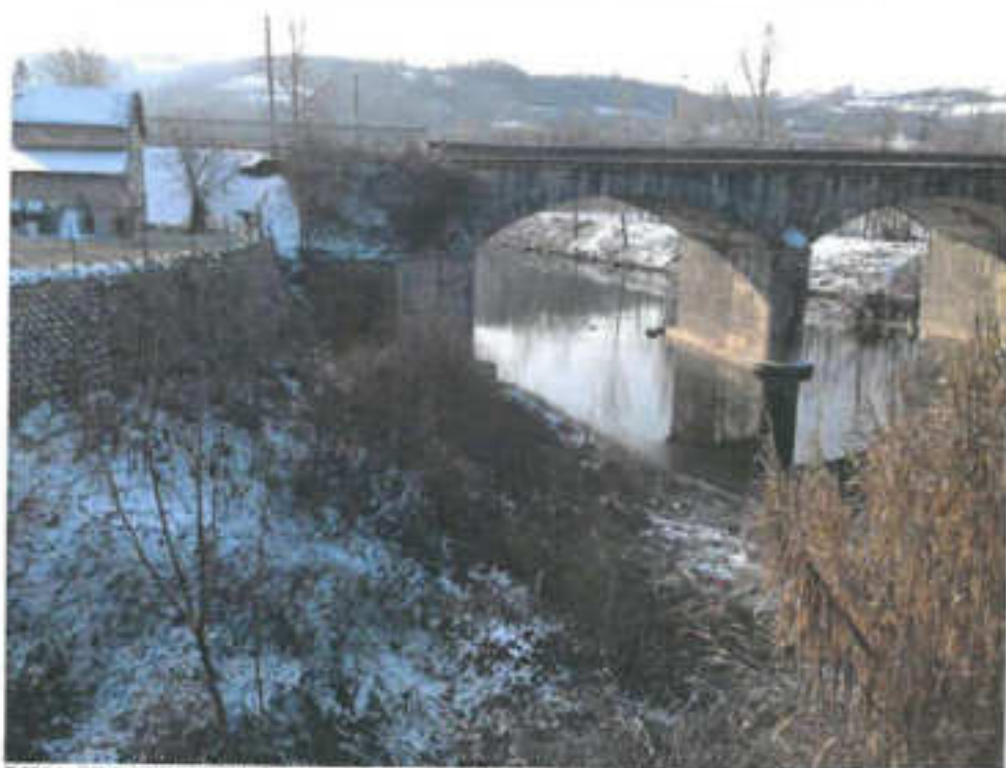
RIVA SINISTRA DEL FIUME A VALLE DEL PONTE FERROVIARIO
