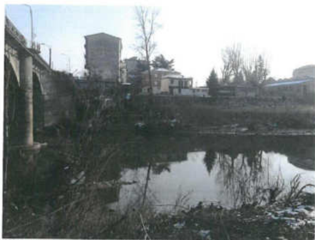
ZONA A VALLE DEL PONTE – ACCESSO AREA DI CANTIERE
