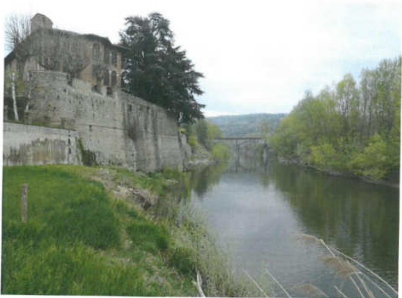
Foto della zona di intervento a monte del ponte ferroviario
